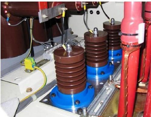
**Abb. 7.** ON-line Messung mit installierten Koppelkondensatoren
